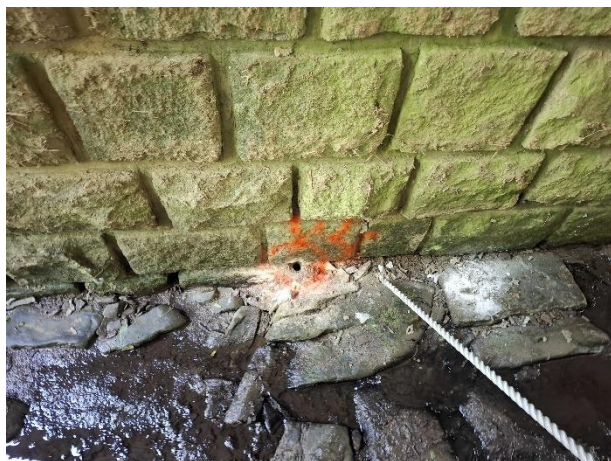
Byla detekována zakládací řada obkladového kamene, následoval beton základu 60 cm.
